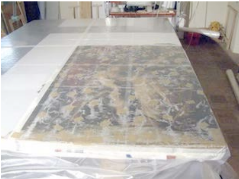
Tavola 38. La busta è stata divisa e segnata con nastro adesivo in quattro rettangoli uguali, la carta giapponese è stata collocata oltre i limiti segnati che sono stati invece rispettati nella fase di imbibizione del consolidante. La colletta bagnando la carta giapponese evidenzia la zona trattata
