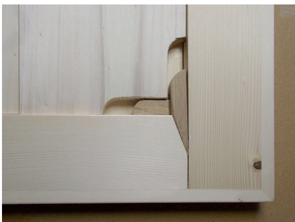
Figura 4. Sistema di espansione a biette, la bietta verticale è a forcella (doppia bietta)
