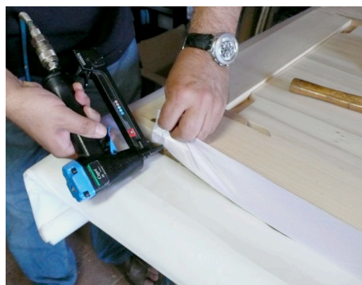
Figura 8. Fissaggio con graffette della tela
